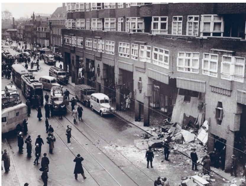
Het flatgebouw 'Amstelstein' aan de Vijzelstraat, na gedeeltelijke instorting, 1955. (ANEFO, SAA)
