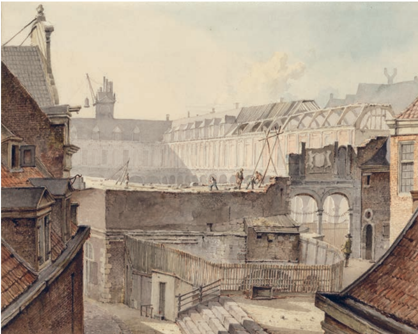
De sloop van de Beurs van Hendrick de Keyser op het Rokin, 1837, gezien vanaf de Beurssteeg achter de Dam. (K. Kasparus, SAA).
