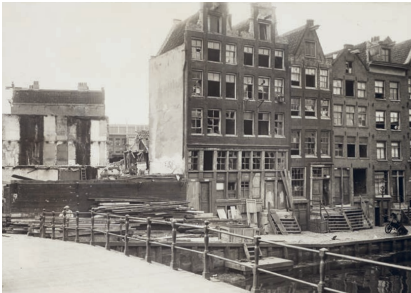
Kaalslag in de Jodenbuurt als gevolg van grootschalige onbewoonbaarverklaringen. Foto vermoedelijk genomen op Vlooienburg, 1928. (Internationaal Persfoto Bureau NV, SAA)
