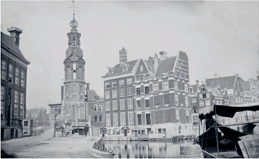
De 'Engelse Huizen' op het Muntplein, gezien vanaf de Binnen-Amstel in de richting van de Bloemenmarkt (links op de achtergrond) en het Rokin (rechts), ca. 1867-1877. (A. Jager, Collectie Kunsthandel Gebr. Douwes, SAA)
