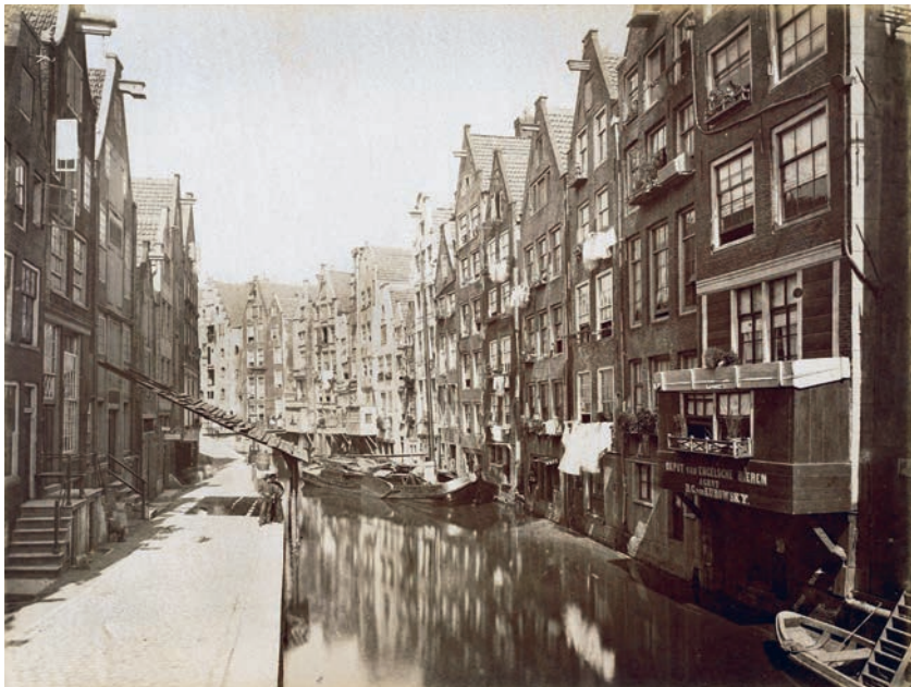
Oudezijds Achterburgwal met oude huizen, sommige met houten hangkeukens. Foto ca. 1880-1890. Vrijwel alle bebouwing is hier later door nieuwbouw vervangen. (H. de Louw, Collectie Frits Knuf, SAA)
