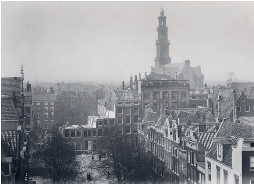
Afbraak van huizen aan de Herengracht ten behoeve van de Raadhuisstraat, 5 april 1896. Gezien vanaf de voormalige Warmoesgracht in westelijke richting. (J. Olie, Collectie Jacob Olie Jbz, SAA)
