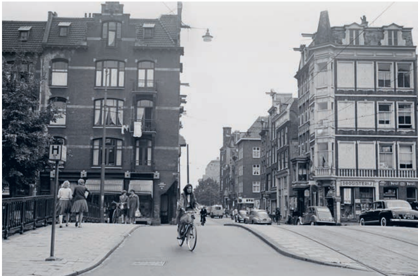
De Weesperstraat bij de kruising met de Nieuwe Prinsengracht, voor de afbraak en verbreding van de straat, 1960. (A.F. Albregt, SAA)
