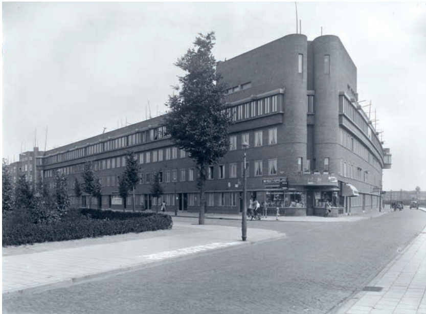
'De Billen van Wijdeveld', hoek Insulindeweg en Celebesstraat, vlak na de bouw in 1920. (Gemeentelijke Dienst Volkshuisvesting, SAA)
