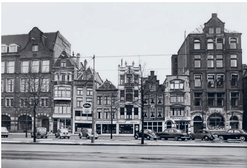
Rokin 53-67, voor de bouw van de Optiebeurs. (Dienst Ruimtelijke Ordening, SAA)
