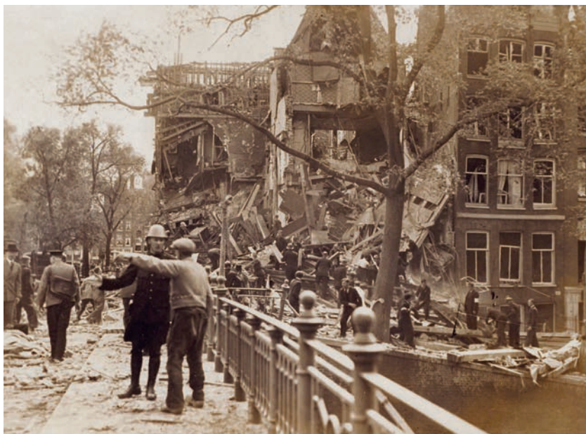
Ravage na een bominslag op de hoek van de Herengracht en de Blauwburgwal, 1940. (Vereenigde Fotobureaux NV, SAA)
