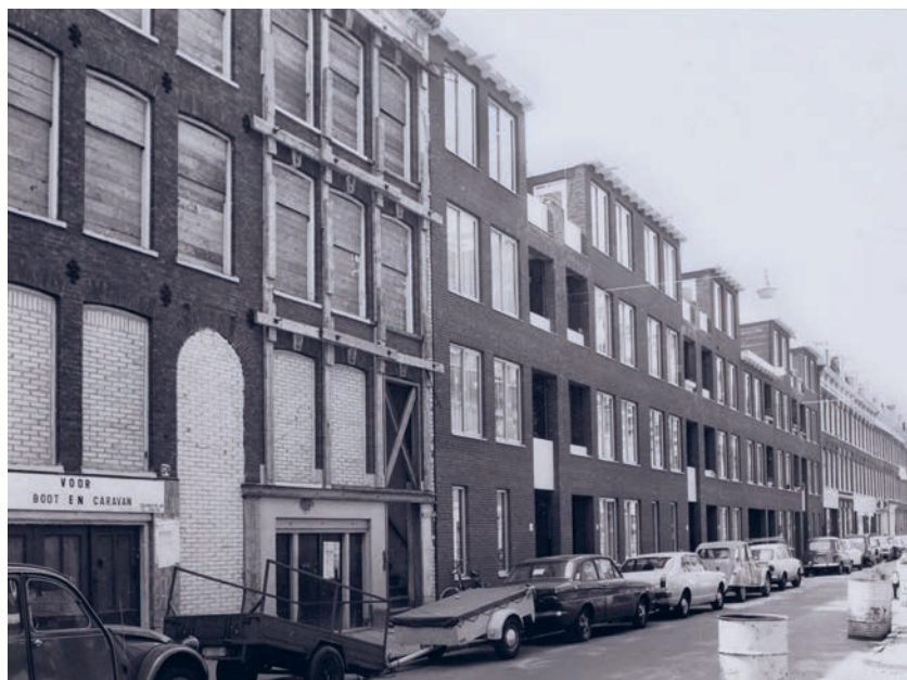
Sloop en nieuwbouw ter hoogte van Govert Flinckstraat 156-168, ca. 1974. (Gemeentelijke Dienst Volkshuisvesting, SAA)
