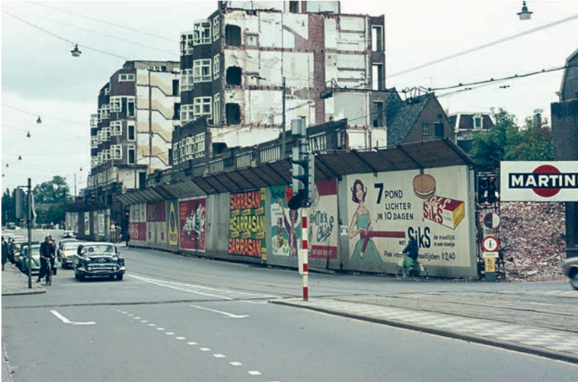
De sloop van Amstelstein in de Vijzelstraat, 1955. (C. Dekker)
