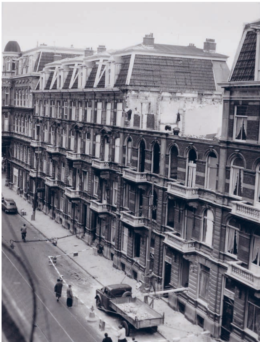
Sloop van woonhuizen aan het Westeinde die tegen de rug van de Galerij van het Paleis voor Volksvlijt waren gebouwd, 1960. (J. van Bilsen, SAA)
