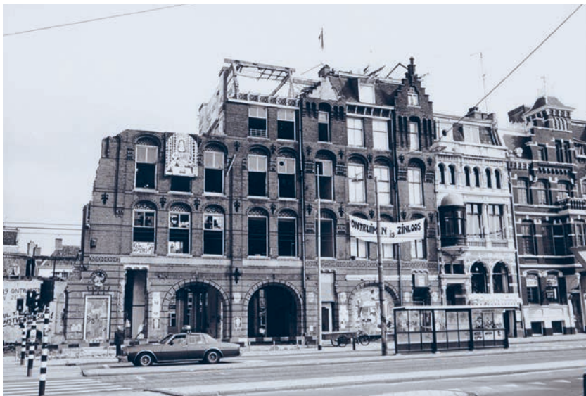
Gebouw 'De Grote Wetering' aan de Weteringschans tijdens de sloop, 1981. (M. Alberts, SAA)
